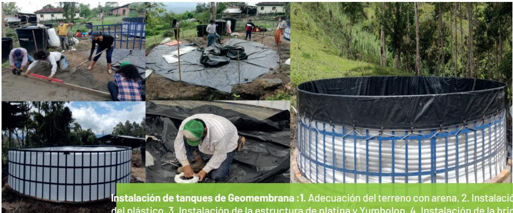
**Instalación de tanques de Geomembrana :** 1. Adecuación del terreno con arena, 2. Instalación del plástico, 3. Instalación de la estructura de platina y Yumbolon, 4. Instalación de la brida en la geomembrana, 5. Instalación de la geomembrana (resultado final)
