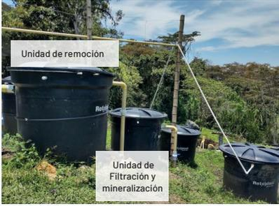
Unidad de filtración y mineralización
